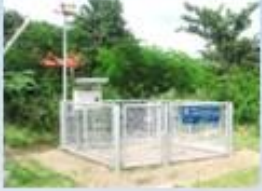
สถานีเตือนภัยด้วยป้ายแจ้งเตือน
